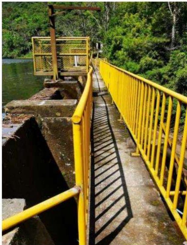
Figura 09: Passarela sobre a Barragem da ETA Debossan
