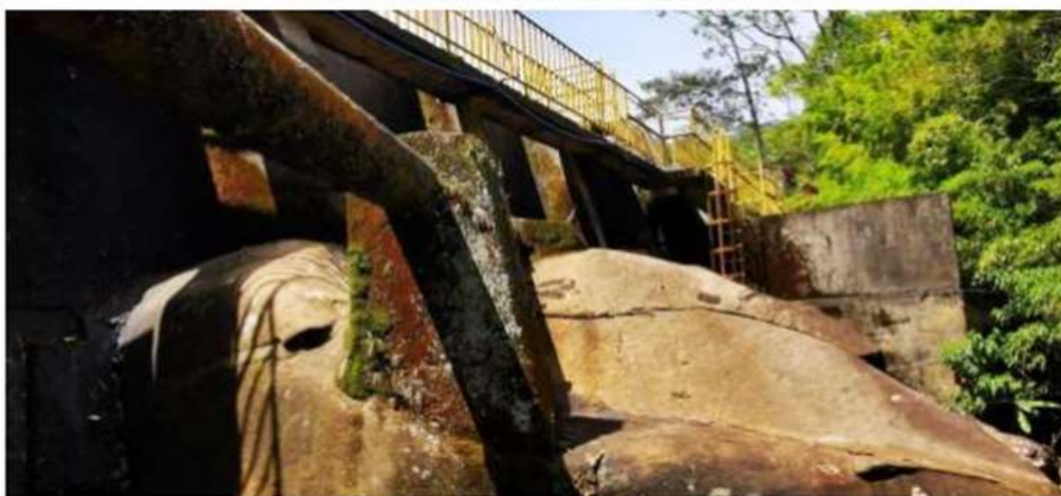
Figura 06: Barragem ETA Debossam - Contrafortes tipo Ambursen
