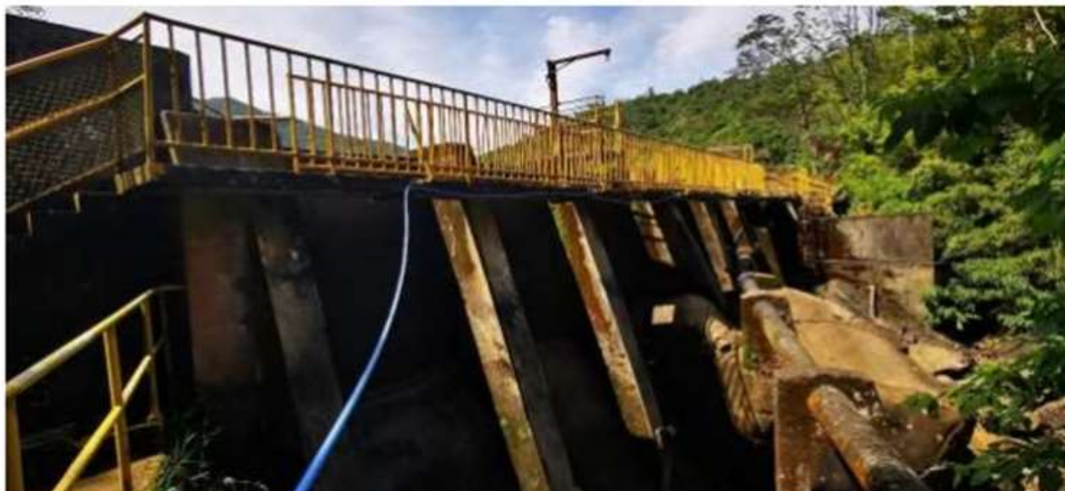
Figura 05: Barragem ETA Debossam - Estrutura em concreto
