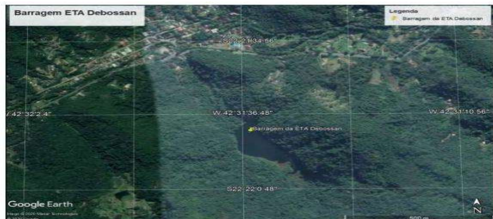
Figura 03: Barragem da ETA Debossan - Localização Fonte: Google Earth
