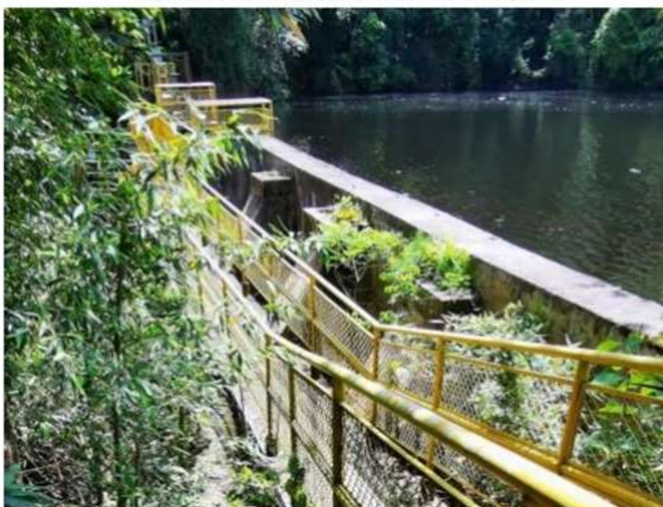
Figura 08: Ombreira esquerda da Barragem da ETA Debossan
