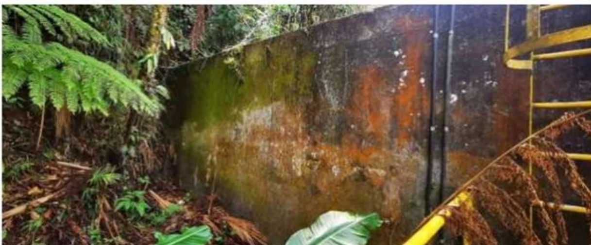
Figura 07: Ombreira direita da Barragem da ETA Debossan
