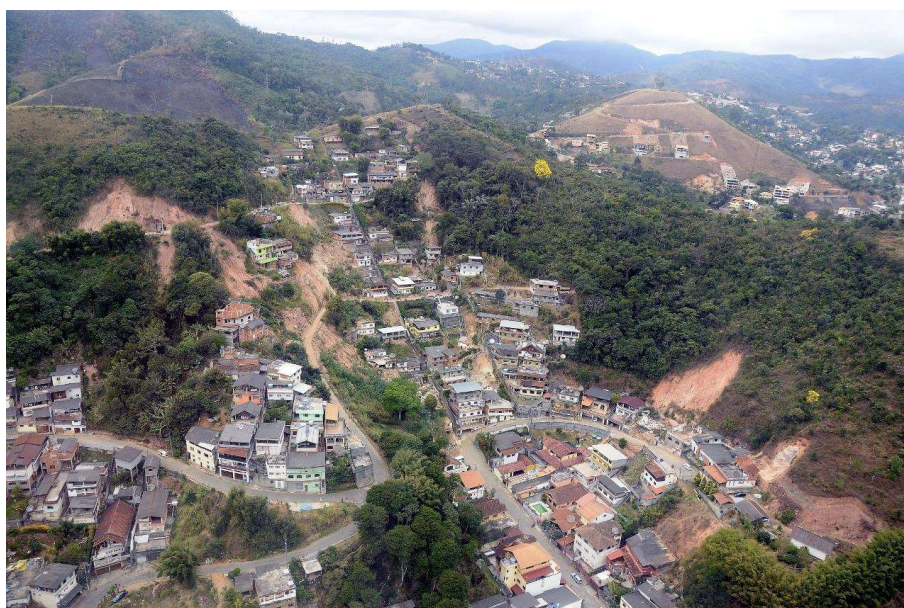
Figura 08: Deslizamentos no bairro Vilage, Nova Friburgo - 2011 (Fonte: SEMDEC)
