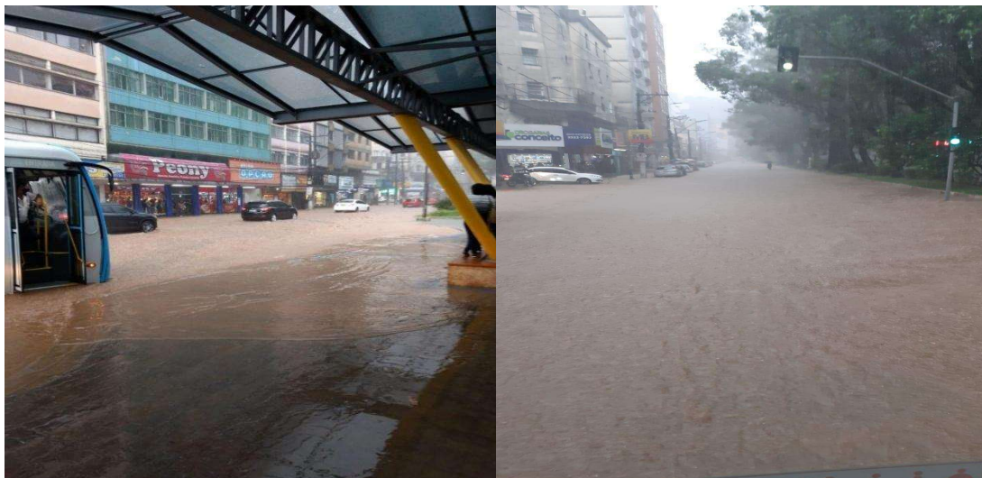
Figura 12: Alagamento - Centro, Nova Friburgo - 2021 (Fonte: SEMDEC)
