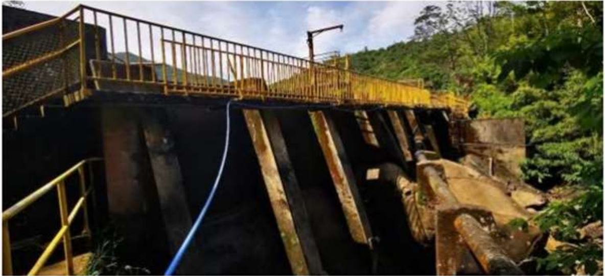
Figura 05: Barragem ETA Debossam - Estrutura em concreto
