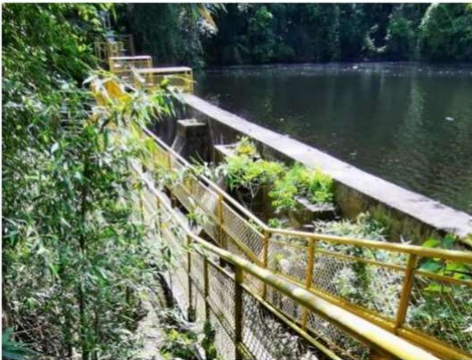
Figura 08: Ombreira esquerda da Barragem da ETA Debossan
