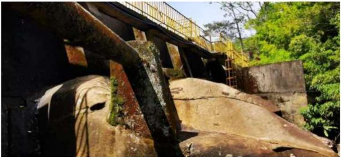
Figura 06: Barragem ETA Debossam - Contrafortes tipo Ambursen
