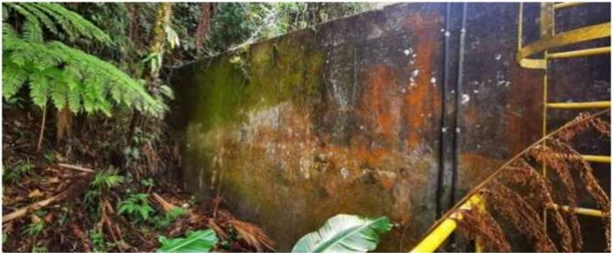
Figura 07: Ombreira direita da Barragem da ETA Debossan
