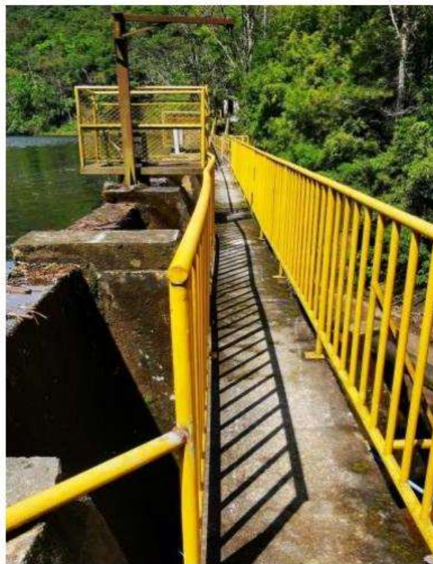
Figura 09: Passarela sobre a Barragem da ETA Debossan
