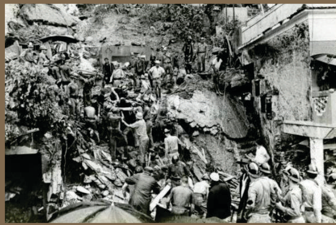
Acima: Deslizamentos de terra e caos no Rio de Janeiro em 1966. Foto do arquivo do Correio do Povo.
